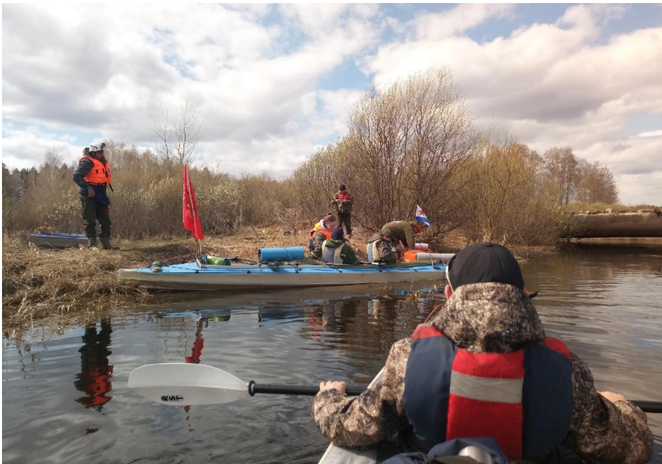
Фото 9. Обнос моста в районе газопровода. Справа видна конструкция моста.
